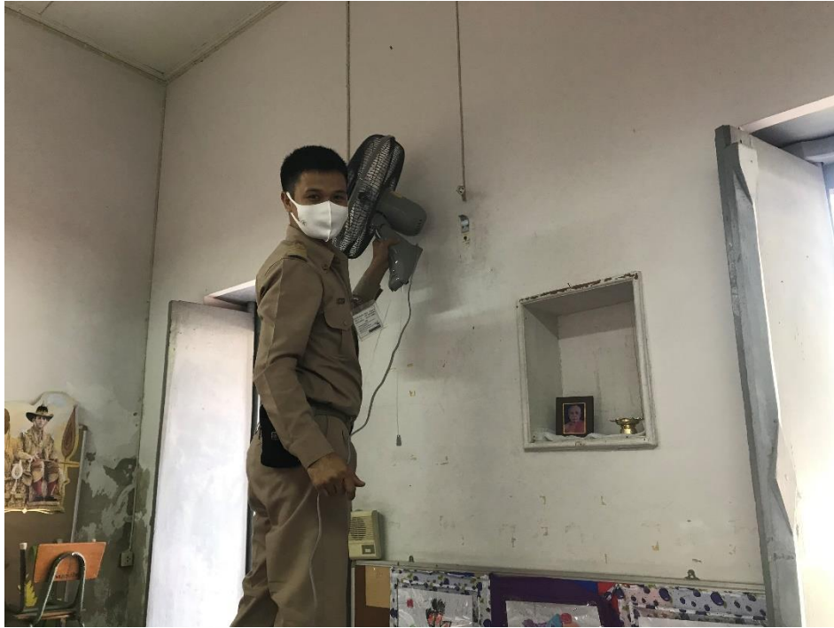
ครูดำเนินการเปลี่ยนพัดลมใหม่แทนพัดลมเก่า
