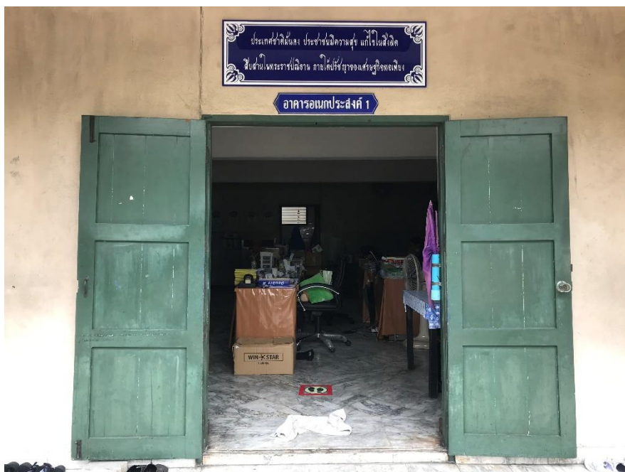
ป้ายที่ติดเสร็จแล้วหน้าอาคารเนกประสงค์ 1 (อาคารชั้น ป.6)
