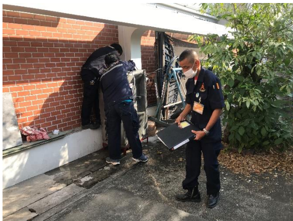
งานได้รับการแก้ไขเรียบร้อยโดยการย้ายสถานที่ติดตั้งตู้ทำความเย็นน้ำดื่มไปที่ใหม่
