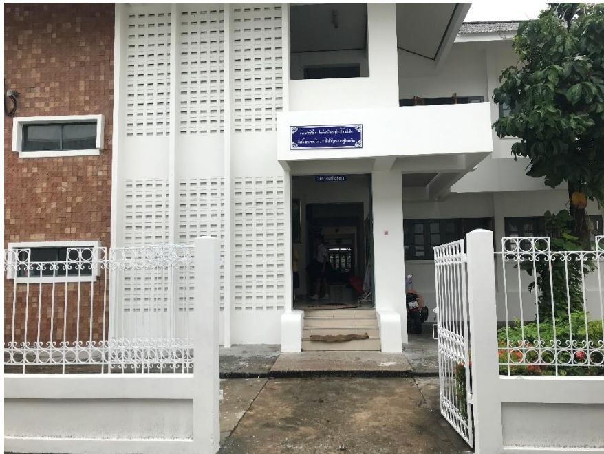
ป้ายที่ติดตั้งแล้วหน้าอาคารอเนกประสงค์ 3 (อาคารชั้นมัธยมศึกษา)
