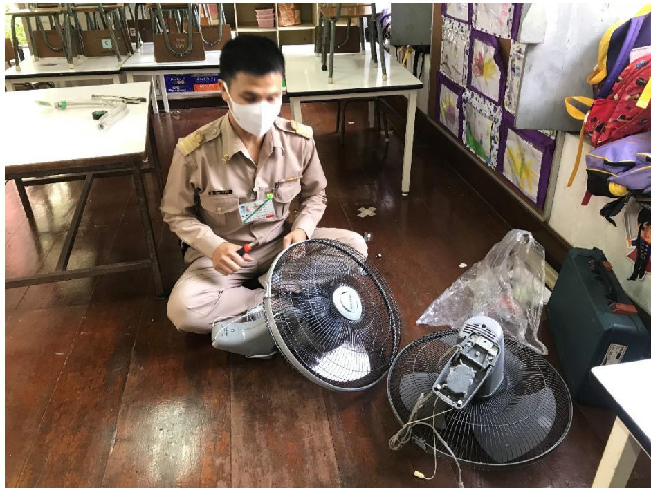
ครูดำเนินการประกอบและติดตั้งพัดลมเครื่องใหม่
