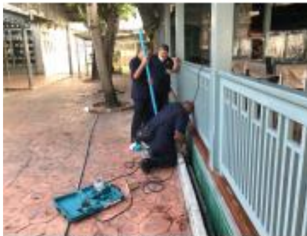
ภาพเจ้าหน้าที่กำลังดำเนินการซ่อม
