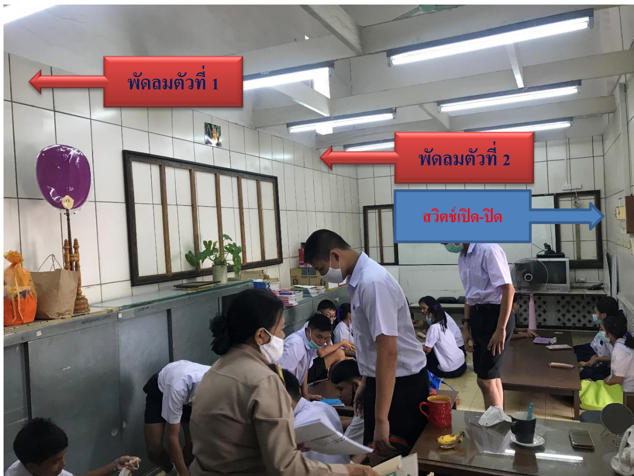
จุดที่จะทำการติดตั้งพัสดุ สวิตช์เปิด-ปิด และเดินสายไฟ
